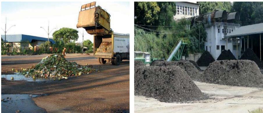
**Figura 2: Pátio de compostagem de resíduos orgânicos no CTR da BR-040, em Belo Horizonte (esq: local de descarga; dir: local de maturação)**
