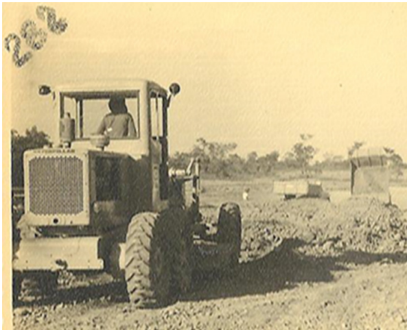
Figura 06: Máquinas realizando limpeza e terraplanagem na BR 174 em 1970
